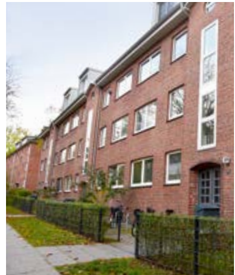
Der Hauseingang Veerstücken 15 ist einer von fünf, bei dem Wichern in diesem Jahr das Treppenhaus saniert hat.
