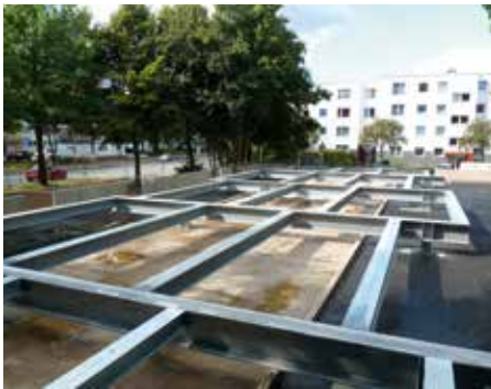
Das Gebäude wurde in Leichtbauweise auf einem Stahlgitter über der Parkpalette errichtet.
